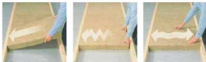
Вставьте плиту одной стороной в каркас
